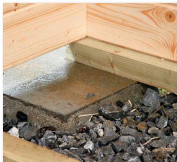
Verdichtetes Schotterbett mit Gehwegplatten als Minimaluntergrund für die Errichtung eines Hauses.
